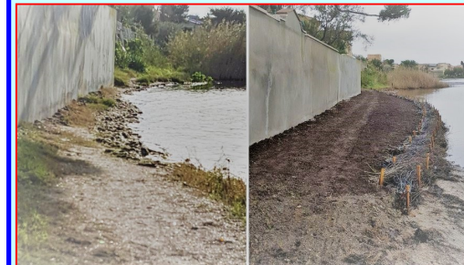
État de la berge avant et après pose de la fascine ouest. (Photos Le Midi Libre du 21/11/2019)
